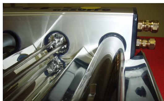
éppen lehúzzuk az egyik üvegsövet egy U-csöves kollektorról
